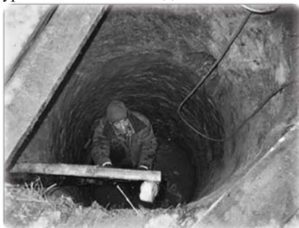
Копается шахта без колец до пяти метров без проблем.
