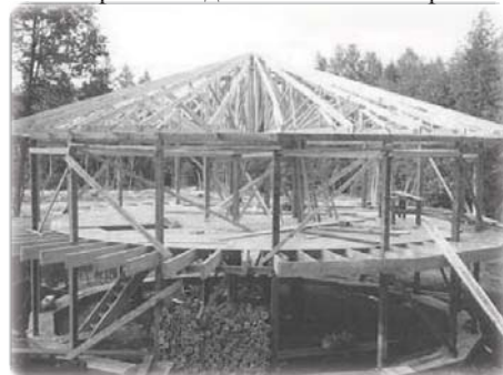
Возведение каркаса дома.
