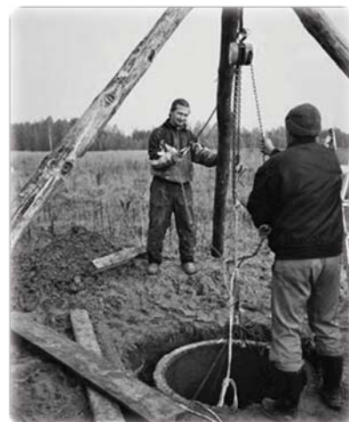
Опускаем кольцо с помощью треноги и верёвки.
