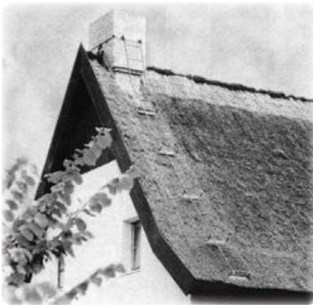
Рис. 2. Дымовая труба размещена по линии конька камышовой кровли.
