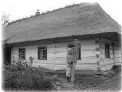
Крыша должна быть под углом менее 45 градусов
