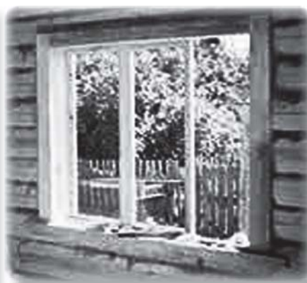
На фотографиях, расположенных слева и справа, изображён оконный блок, который мы рекомендуем использовать при строительстве рубленого дома. Способ установки называют «окосячка с забривкой».
